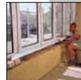
Тип AL 1L: установка подоконников.
