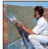
Тип НАК: разравнивание верхних слоев штукатурки.
