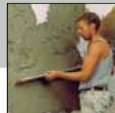
Тип TRK: затирка нижних слоев штукатурки.
